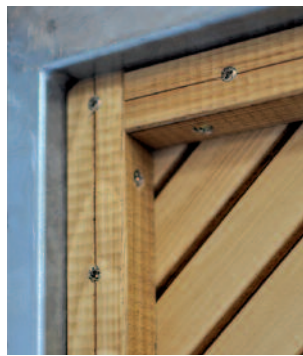
Flexible Befestigung des Torbelags mit Holzschraubleisten
