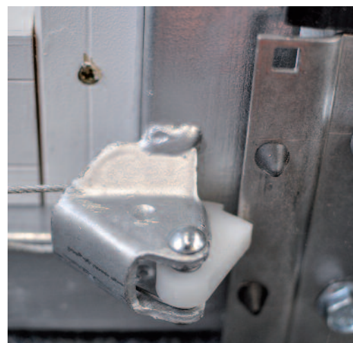
Die seitliche Verriegelung mit den Pfullendorfer Schließriegeln
