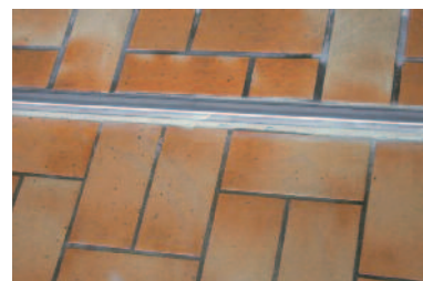
Damit nichts rostet – Schwellenschiene aus V2A
